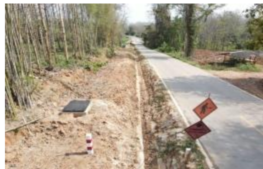
ภาพที่ 1.9 ระบบส่งน้ำพร้อมอาคารประกอบคลองส่งน้ำสาย (LMP) ความยาว 1,600 เมตร
