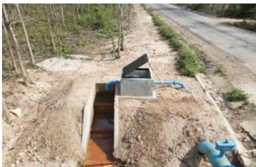
ภาพที่ 1.9 ระบบส่งน้ำพร้อมอาคารประกอบคลองส่งน้ำสาย (LMP) ความยาว 1,600 เมตร
